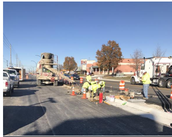
Pouring concrete center curb
